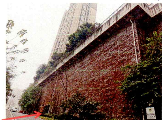
估价对象外观现状
